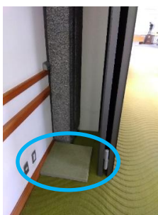
アネックスホール連絡通路
