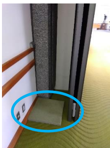
アネックスホール連絡通路
