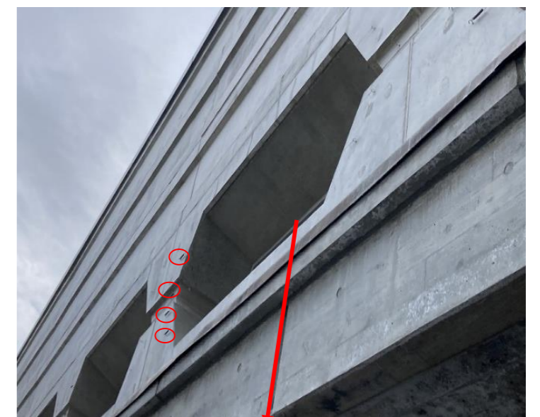
各枠毎に4本のワイヤー設置有り、ワイヤーは取外さず、短いポールを使用すること。
