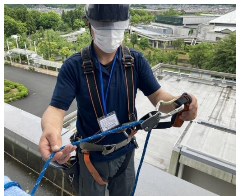
オープンスリング・ロープ等で固定
