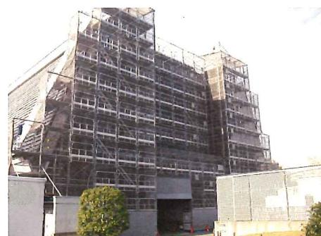
なお、平成26年度にメインホール（集中工事期間6月上旬～10月末）の工事が完了すれば、建物全体において、建築基準法における新耐震基準の耐震性能が確保される。耐震改修工事に併せて、内装及び設備、外壁などの改修も実施し、機能性及び利便性を高める予定である。
