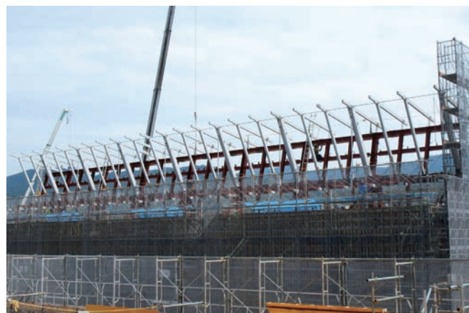
▲ 上：完成時イメージ図、下：ガラス屋根を支える鉄骨トラス
