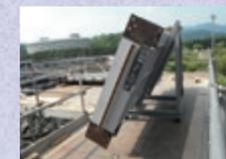
耐震補強用鉄骨制震パネル
