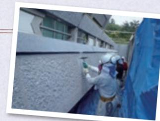
コツコツ仕上げ (ハンマーの叩き出しで岩肌調の壁面を作成)
