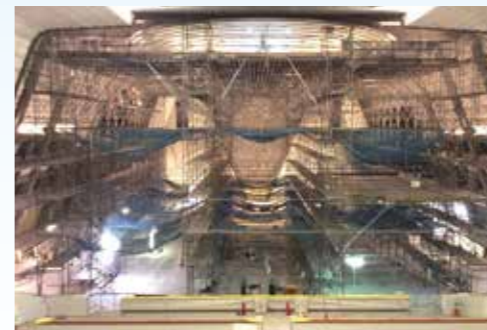
メインホール耐震工事▲
