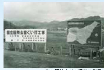
▲施工開始当時の現地の様子▲
