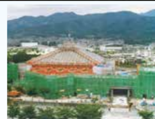
▲イベントホール建設中の様子
