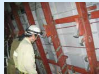
▲外壁耐震改修工事
